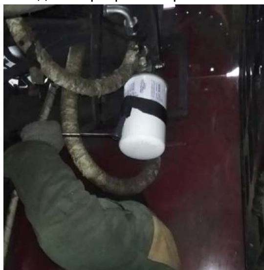
Рисунок 3.12 – Вид на сливной фильтроэлемент, демонтируемый при помощи ключа фильтра
