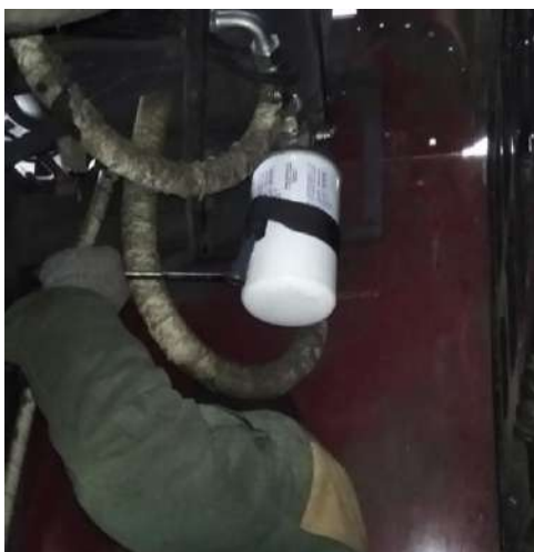
Рисунок 3.11 – Вид на сливной фильтроэлемент, демонтируемый при помощи ключа фильтра
