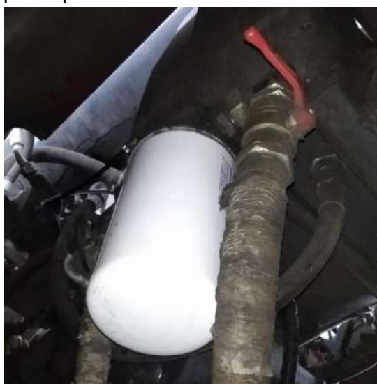
Рисунок 3.9 – Вид на перекрытый кран сливного фильтроэлемента
